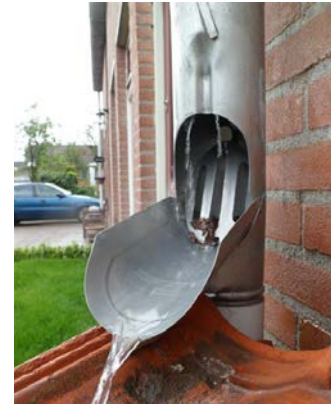
Dakwater opvangen en laten infiltreren
