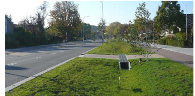
Voorbeeld van een straatprofiel waar ruimte is voor regenwater infiltratie en afvoer
