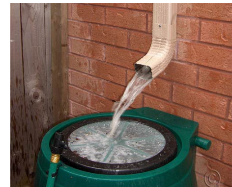
Dakwater opvangen en laten infiltreren
