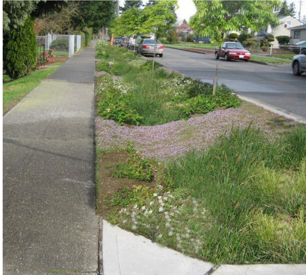
opvang hemelwater in de berm
