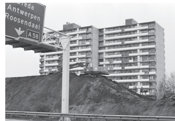
Omlegging van de afslag en de aanleg van de geluidswal
