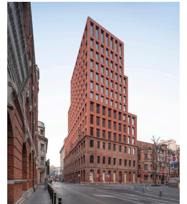
Afleesbare structuur, alzijdigheid, geleding in de massa, afleesbare plint, romp en kop, bijzondere materialisatie
