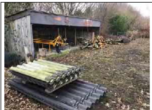
Aangetroffen (asbestverdacht) plaatmateriaal ter plaatse van boring B42, B43.
