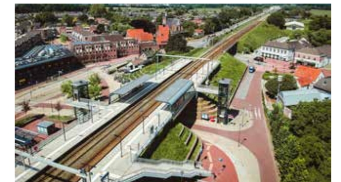
Combinatie van station met onderdoorgang
