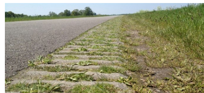
Waterpasserende verharding, grasbetontegels
