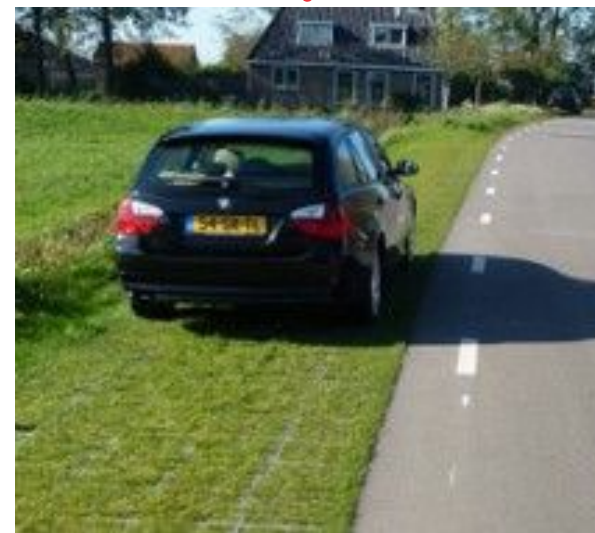
Langparkeren op grasbetontegels
