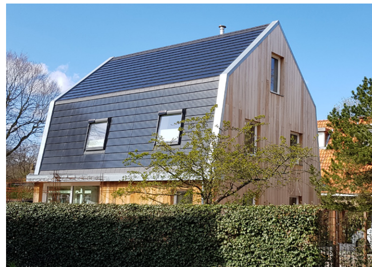
Mansardedak met zonnepanelen
