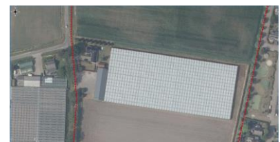
Figuur 33. Luchtfoto locatie.
