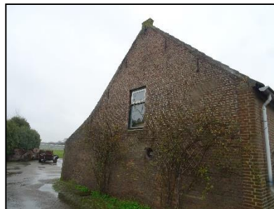
Figuur 27. Detailopname kopgevel met gemetselde daklijst.
