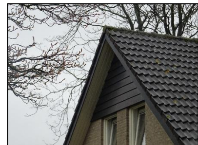
Figuur 21. Gevelbetimmering en kantpannen, bieden mogelijk onderkomen aan gebouwgebonden vleermuizen.
