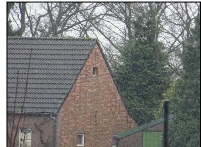
Figuur 9. Open raam in de nok van de schuur. Dergelijke openingen worden vaak door kerkuilen gebruikt.
