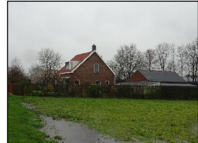
Figuur 25. Achteraanzicht van woonhuis en bijbehorende schuur.
