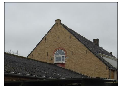
Figuur 51. Detailopname kopgevel.
