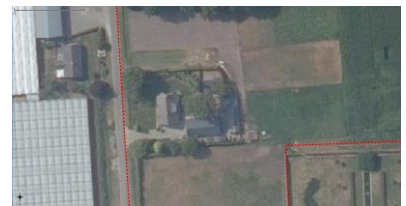
Figuur 18. Luchtfoto locatie.
