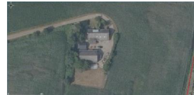
Figuur 28. Luchtfoto locatie.
